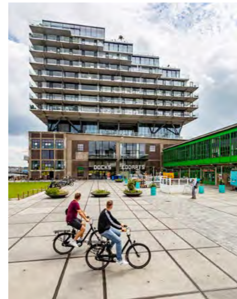
Fenix I | Rotterdam – Mei architecten
